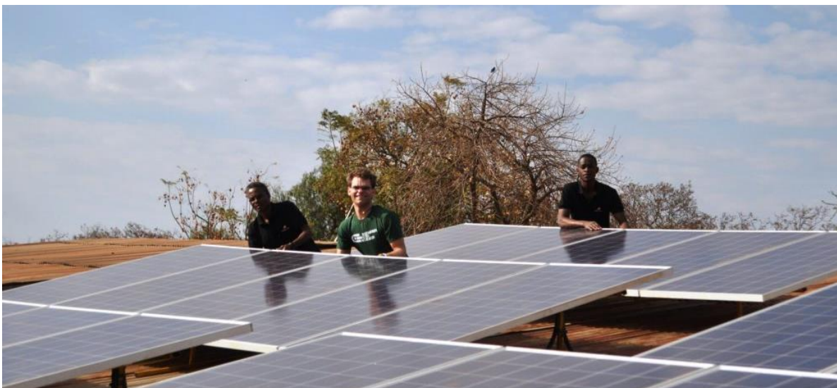
Effektiv klimabistand: Montering av solenergianlegg på sykehus i Tanzania. Foto: K. Fløgstad
